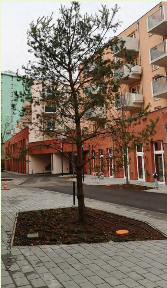
Die Baumscheiben in der Mikrozone in die Oberflächenwasser eingeleitet wird
