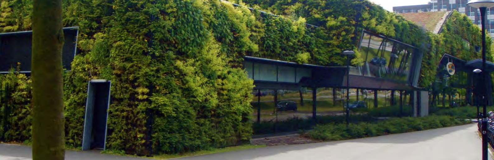
Fassaden- und Dachbegrünung am „Mercator Hallenbad“ in Amsterdam (Architektur: Ton Venhoeven, Bauherr: Sportfondsenbad Nederland, Gemeinde von Amsterdam)
