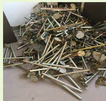
Sortierte Metallfraktionen aus einem Rückbaubjekt
