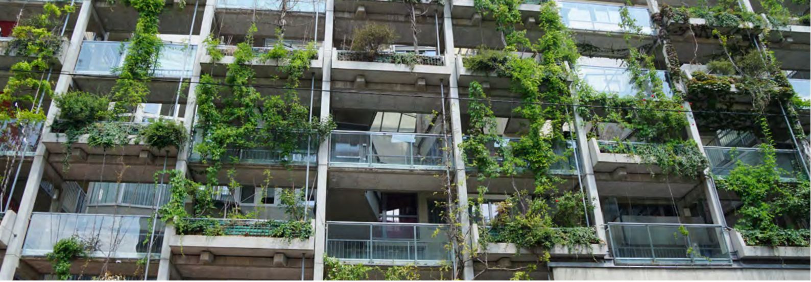
Die „Hängenden Gärten“ in Margarete mit einer intensiven Begrünung der Fassade (Bauherr: Wiener Heim WohnbaugesmbH ; Planung der dargestellten Fassade: RLP Rüdiger Lainer + Partner; ARTEC Architekten, ss|plus architektur)
